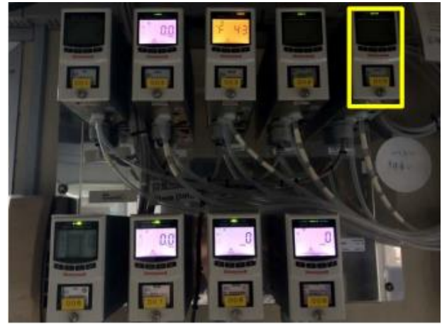
428 實驗室氣體偵測器設置情形，響起警報為黃框位置
