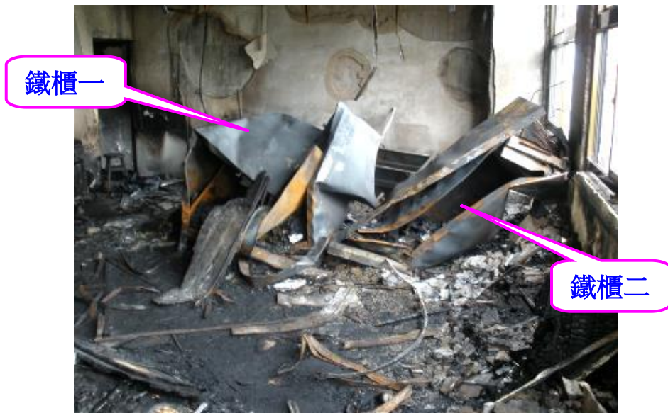
圖三 二個鐵櫃倒塌情形
