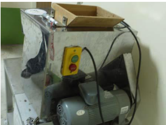
說明：壓麵條機傳動鏈條加裝護蓋
