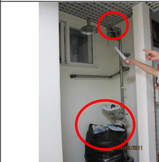
圖 8、實驗室外緊急沖淋設備位置堆放物品且拉環無法使用
