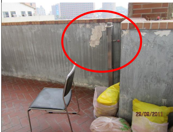
圖 9、逃生設備應定期確認維護(缺緩降機)
