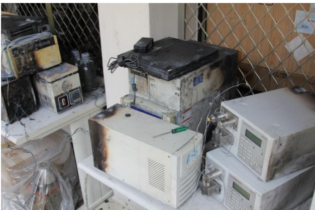
5. 燒毀之儀器設備
