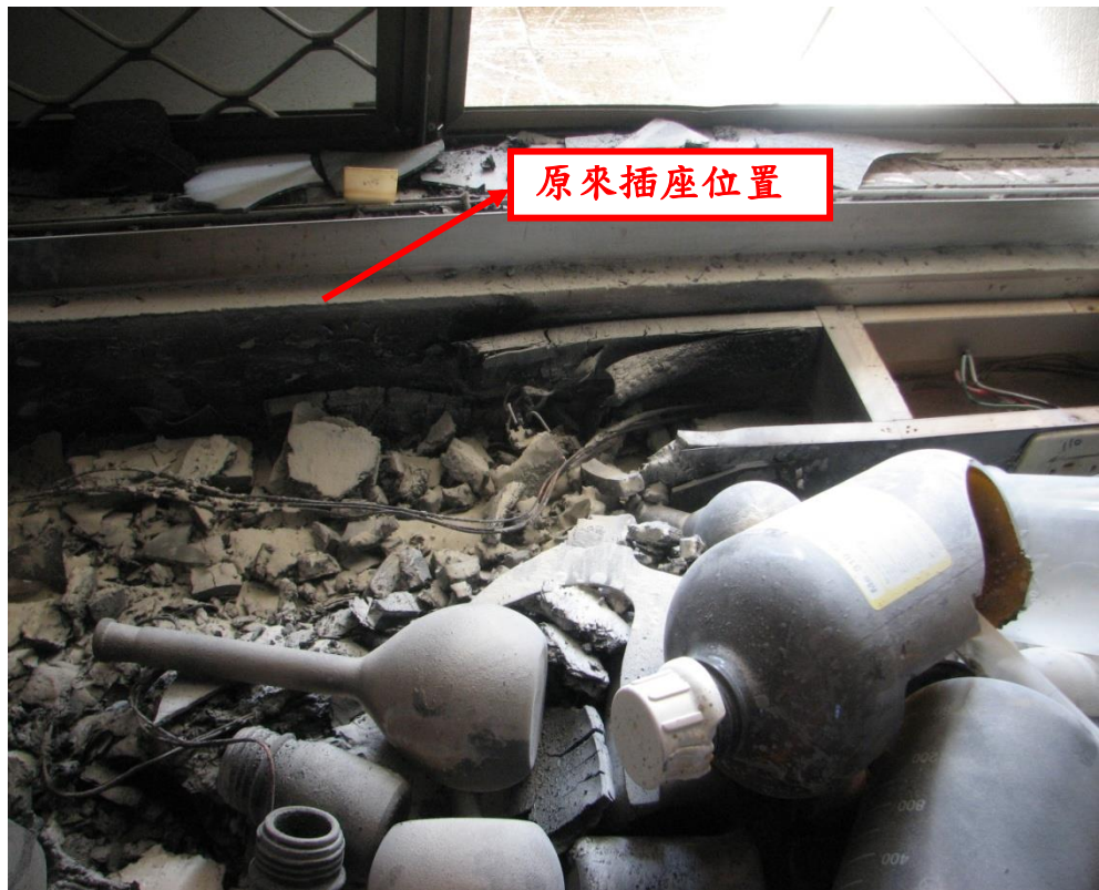
圖一 插座毀損狀況
