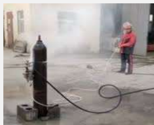
工程基礎作業
