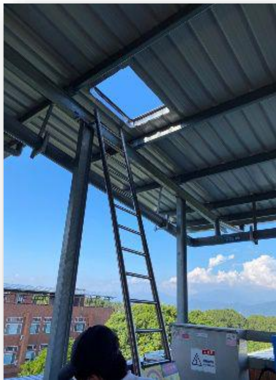
▲圖1、2應於固定式爬梯設置護籠
