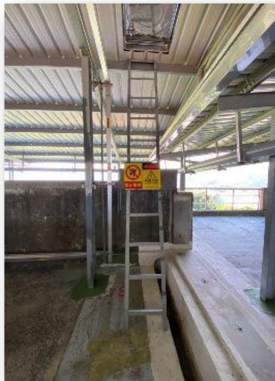
▲圖1、2應於固定式爬梯設置護籠
