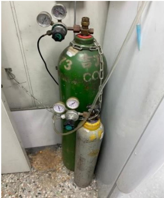
圖4-1及圖4-2： (1)鋼瓶固定位置及方式錯誤。 (2)易引起火災及爆炸危險場所未標示嚴禁煙火。
