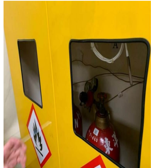
圖4-3： 氫氣鋼瓶抽風儲存櫃透視窗已破損，未修復。
