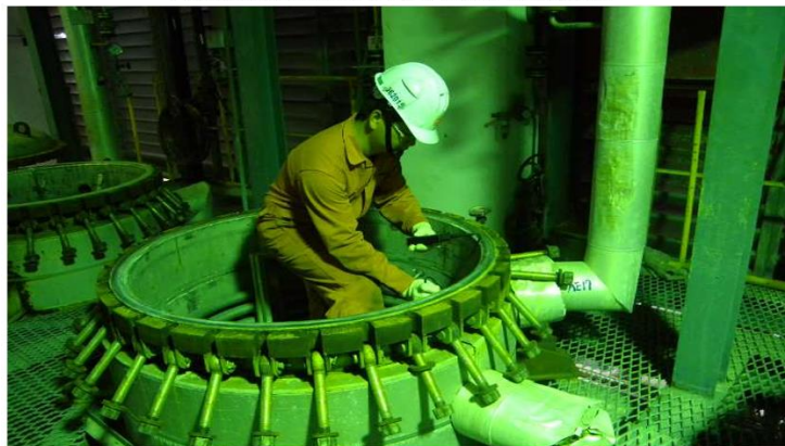
代行檢查機構檢查員進入反應槽實施測厚及確認銲道狀況
