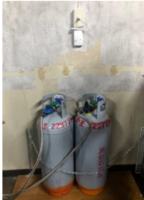
圖4-1及圖4-2： (1)鋼瓶固定位置及方式錯誤。 (2)易引起火災及爆炸危險場所未標示嚴禁煙火。
