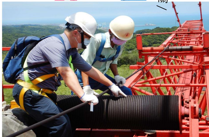
代行檢查機構檢查員至塔吊伸臂處檢查確認鋼索狀況
