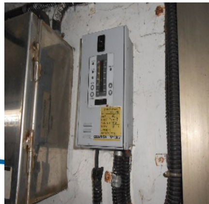
廢液暫存間設置危害氣體偵測警報裝置
