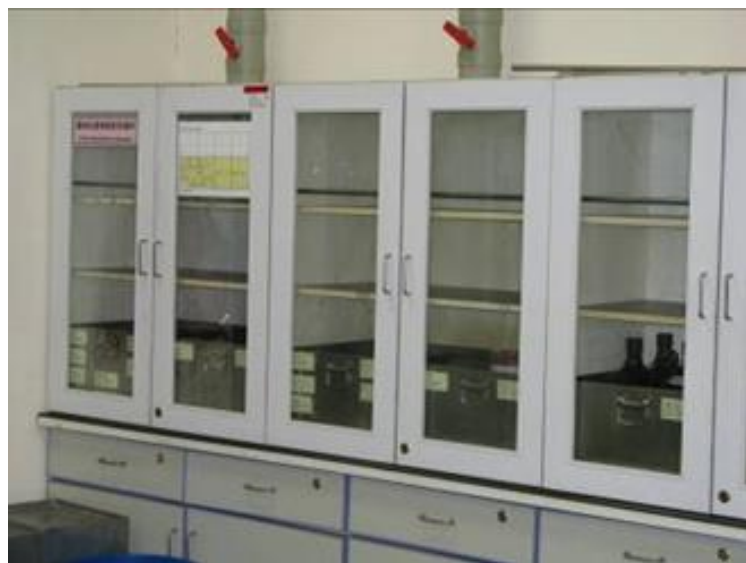
圖3 具通風排氣設備化學品貯存櫃
